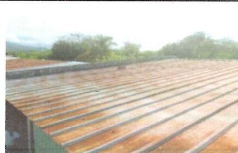
CUBIERTA DE LAMINA Mantenimiento de cubierta de techo de lámina galvanizada existente, lijado, reparaciones, impermeabilización y pintado. Aula 3
