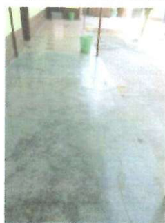
PISO Sustitución de piso de concreto con acabado liso por piso ceramico, incluyendo preparación de superficie, aula 1, 2 y pasillo
