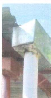
CANALES Y BAJADAS DE AGUA PLUVIAL Sustitución de canales para evacuación de aguas pluviales Material: lamina galvanizada Tipo: lisa, Anclaje: canal sostenido por pescantes metalicos
