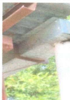
CANALES Y BAJADAS DE AGUA PLUVIAL Sustitución de canales para evacuación de aguas pluviales Material: lamina galvanizada Tipo: lisa, Anclaje: canal sostenido por pescantes metalicos
