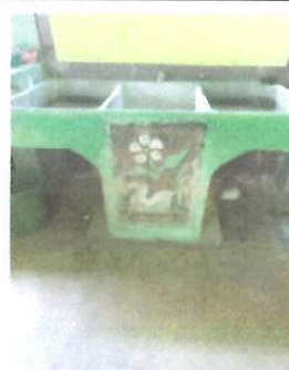
REPARACIÓN O SUSTITUCIÓN DE ÁREA DE COCINA SUSTITUCION DE PILA EN MAL ESTADO
