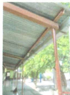
ESTRUCTURA DE TECHO, MANTENIMIENTO DE ESTRUCTURA
